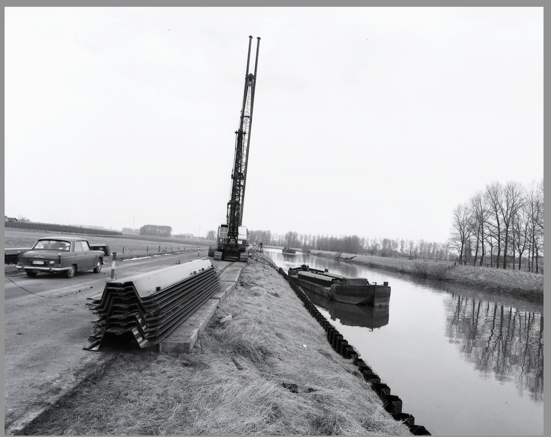
Het plaatsen van damplaten langs het kanaal in Meigem in 1979
