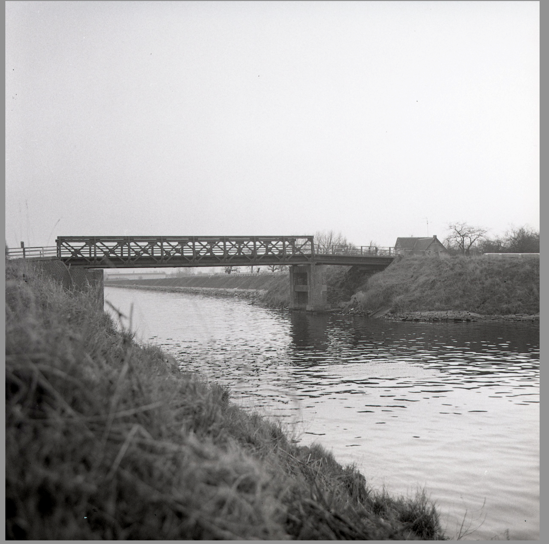
Bachte Brug verdween in 1980. Bachte brug was een type bailey brug die door een genie eenheid van het leger in enkele uren kon geplaatst worden. Deze brug kon voertuigen tot 15 ton dragen.
