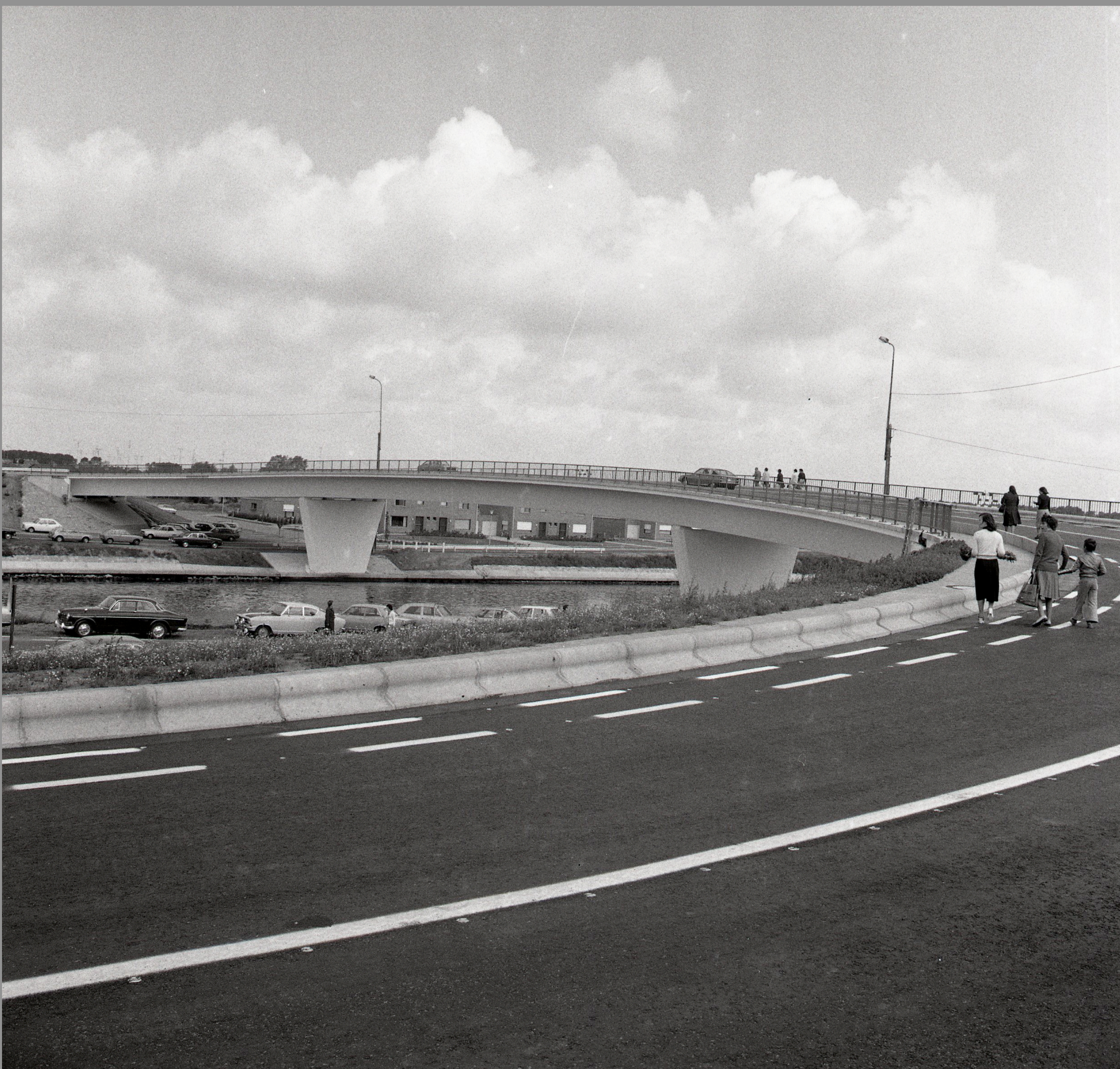
De Kromme Brug (in de volksmond de Bananebrug genoemd) is een betonnen liggerbrug. De brug werd gebouwd in 1977 en bestaat uit drie overspanningen: twee zij-overspanningen van 35 m en een midden-overspanning over het kanaal van 51 m. De totale lengte bedraagt 121 m, de breedte is 14 m. De brug werd genoemd naar haar vorm
