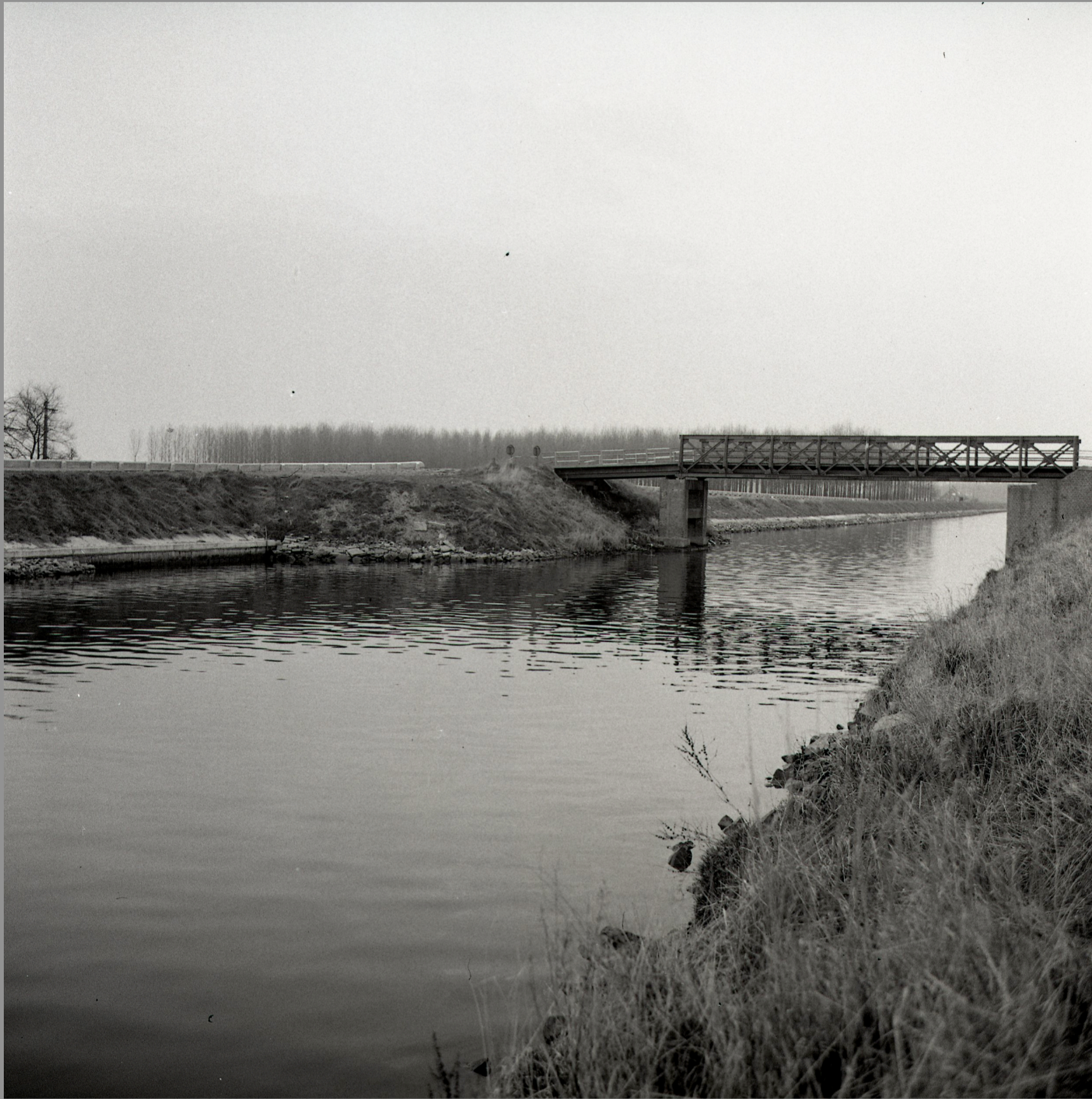
Bachte Brug verdween in 1980. Bachte brug was een type bailey brug die door een genie eenheid van het leger in enkele uren kon geplaatst worden. Deze brug kon voertuigen tot 15 ton dragen.
