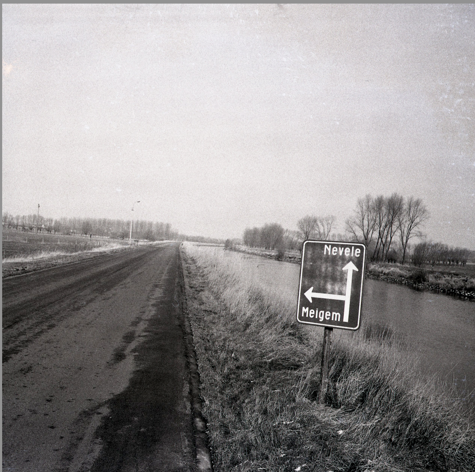
Een gevaarlijke verkeerssituatie langs het kanaal in Meigem in 1978
