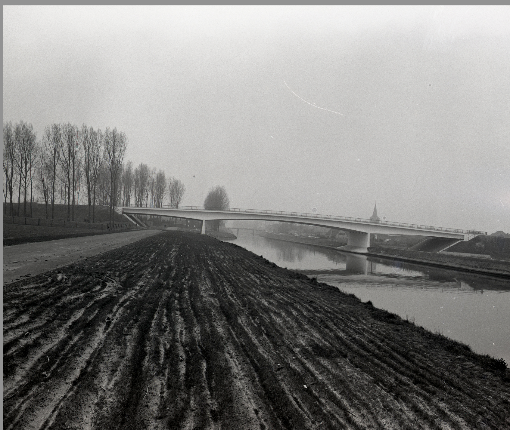
De nieuwe brug voor autoverkeer over het kanaal in Nevele in 1984
